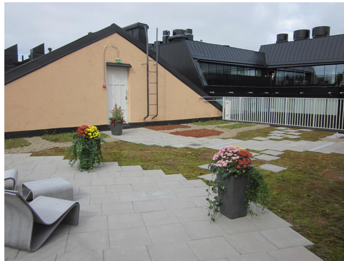
FABIANINKADUN KOEVIHERKATTO HETI ASENNUKSEN JÄLKEEN
